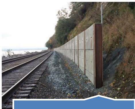
Τοίχοι αντιστήριξης από οπλισμένο σκυρόδεμα
