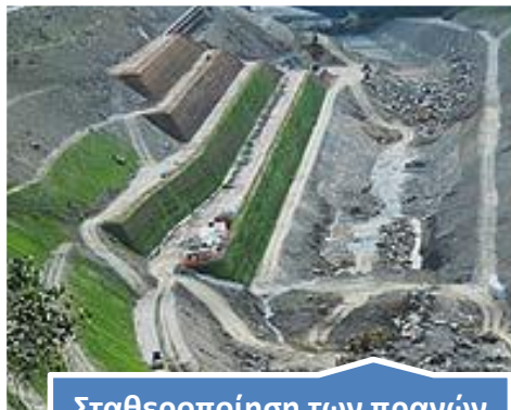
Σταθεροποίηση των πρανών με διαμόρφωση επιπέδων και φύτευση
